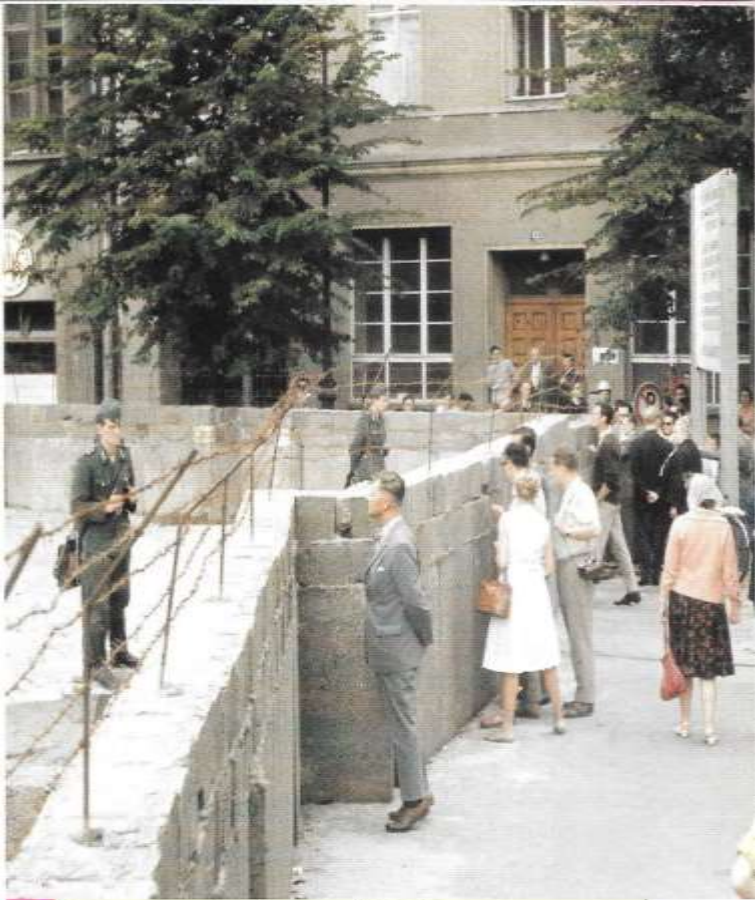
4 La construction du mur de Berlin
